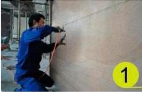
Cubra una capa de zócalo en la superficie de la pared, comúnmente use madera contrachapada de 3 mm, pladur o cualquier material parecido. Clávelos en la pared con pistola de gas.
